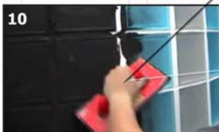
10 Spárovací hmotu nanášíme rovnoměrně pomocí gumové stěrky na spáry mezi tvárnici.
