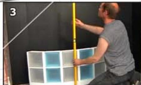
3 Po usazení zkontrolujeme vodorovnou usazení dílce - vodorovnost, a svislost minimálně ve třech bodech.
