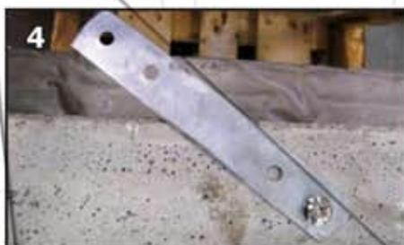
4 Kovové kotvy provedené po obvodě panelu přikotvíme pomocí hmoždinek k přilehlé konstrukci (SDK, Hebel..)
