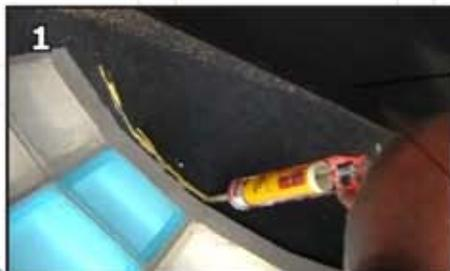
1 Na pevný, vodorovný a očištěný podklad nanese se po celé délce obvodu montážní lepidlo Soudal 48
