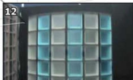
12 Po cca 5-10min. očistíme jednotlivé tvárnice látkou, v případě potřeby použijeme roztok XINTEX.
