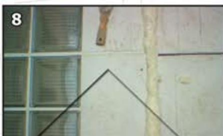
8 Případné mezery po obvodě stěny vyplníme montážní PU pěnou Soudal. Po ztvdnutí pěnu ořízneme do roviny.
