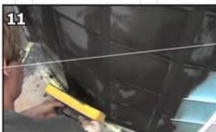
11 Po zaspárování celé stěny necháme 1-3min. zavadnout a poté začneme přebytečnou hmotu vymývat houbou.
